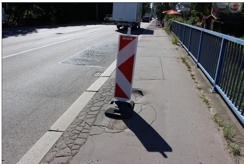
05-pravý chodník - defekt v LA - osazená směrovací deska Z4.JPG
