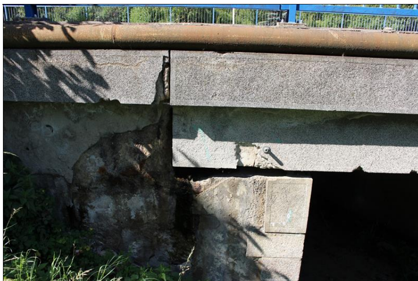
17-opěra 4 levá strana - degradace betonu křídla a úlož.prahu.JPG
