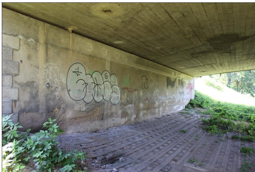
19-pohled na opěru 4 - zatékání z úl.prahu.JPG
