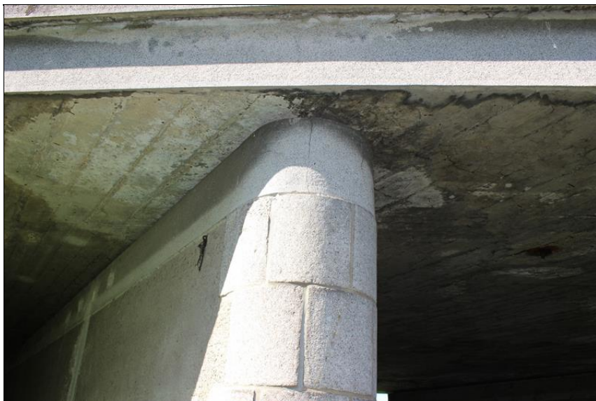
22-temeno pilíře P3 vlevo - svislé trhliny.JPG
