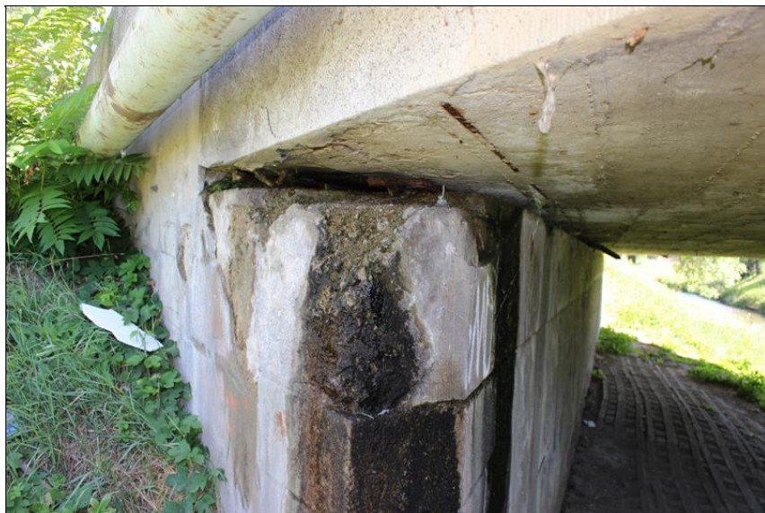
13-pravý roh opěry 1 - zatékání z úložného prahu - silná degradace betonu.JPG
