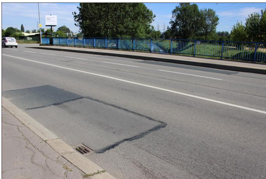
23-celkový pohled na vozovku na mostě - vozovka nerovná - vyjeté koleje - místa trhlinky.JPG
