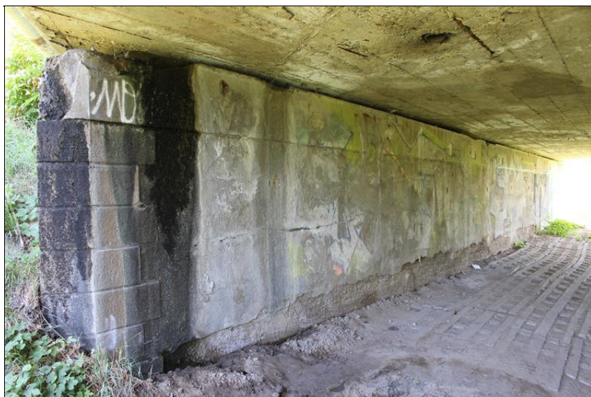
14-celkový pohled na opěru 1 - zatékání z úl.prahu - degradace betonu ve spodní části - vápenné výluhy na pohledu ŽB desky.JPG
