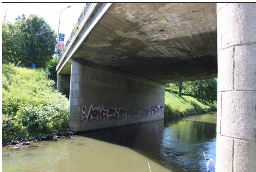
16-pohled na pilíř P3 - vápenné výluhy v podhledu ŽB desky pole 2.JPG
